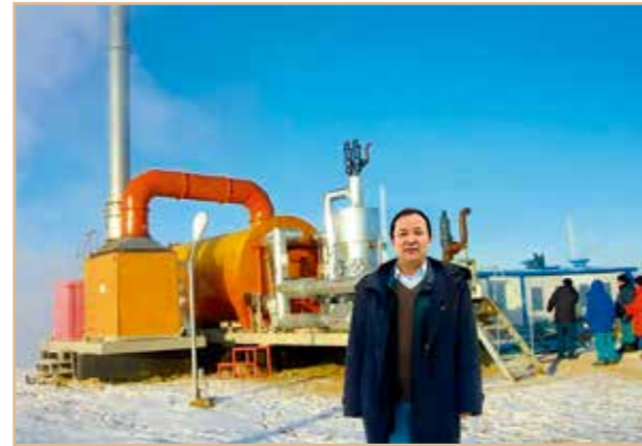
图10 检查过热蒸汽锅炉的注汽质量
