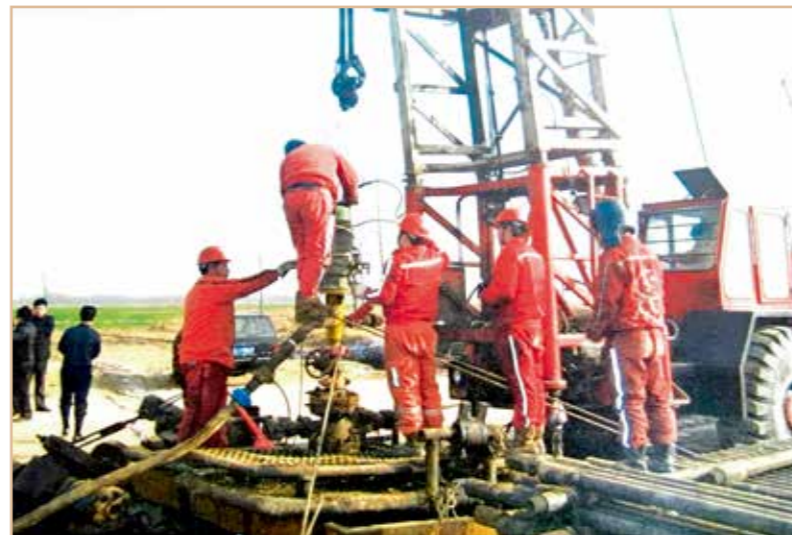
图1 水击泵现场施工
